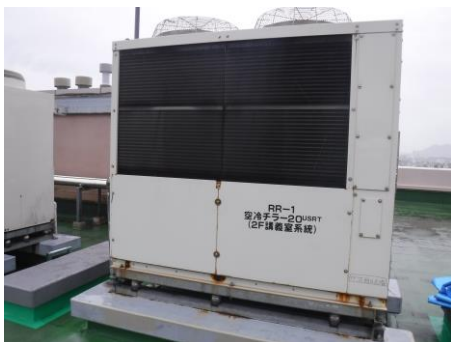
(改修前) 室外機
